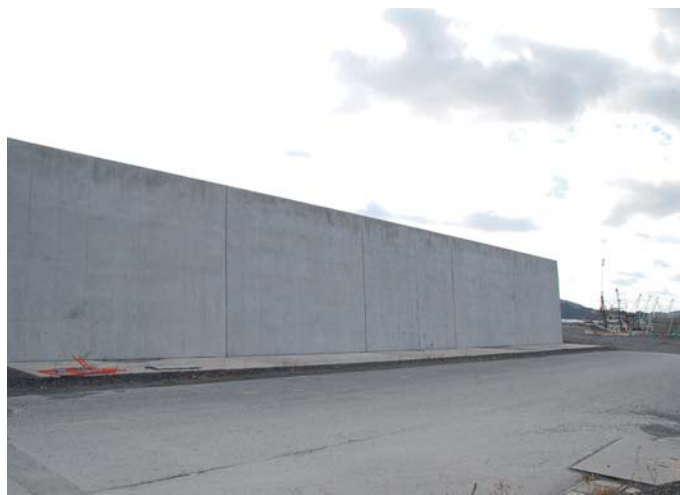
建設中の防潮堤の向こう側に大船渡湾が広がっている (右端に見えるのは係留中の漁船のマスト)
