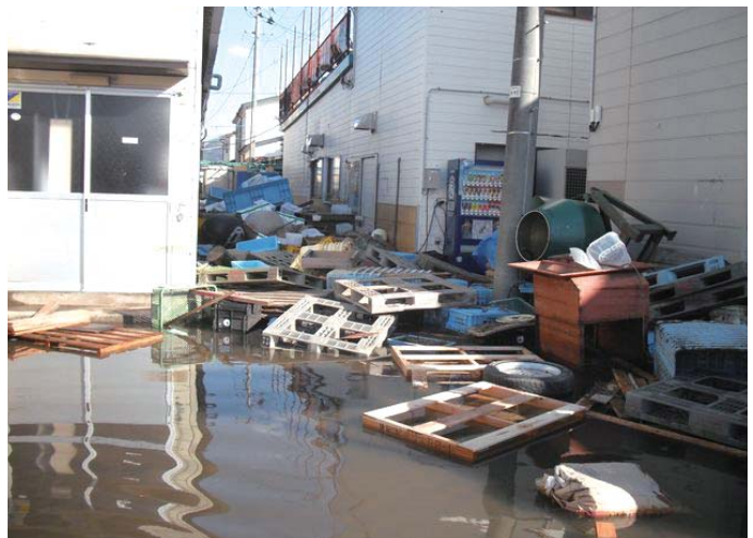
大きな被害にあった工場
