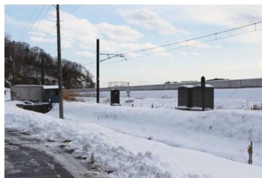
災時は、工場の目の前の線路の防波堤が崩れ、土砂が流された
