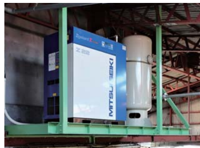
スクリューコンプレッサー ラインの複数機器を一括してパイプで結び稼働できる
