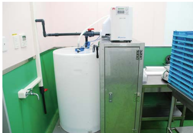
器具や材料の殺菌、洗浄に欠かせなくなった電解殺菌水生成機
