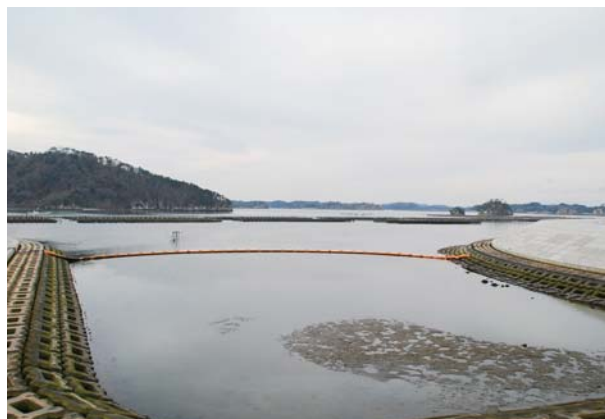
長石商店本社工場前の防潮堤から望む松島湾
