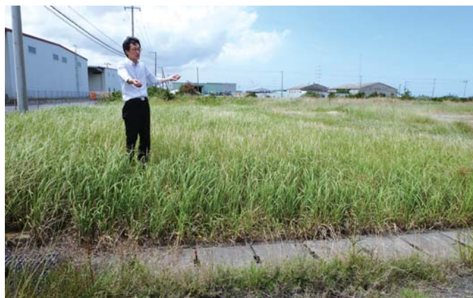
地盤沈下、液状化の状況を説明する藤山さん。地震前は、今藤山さんが立っている高さに道路面が位置していたそう。このエリア一帯が地盤沈下したことを物語る
