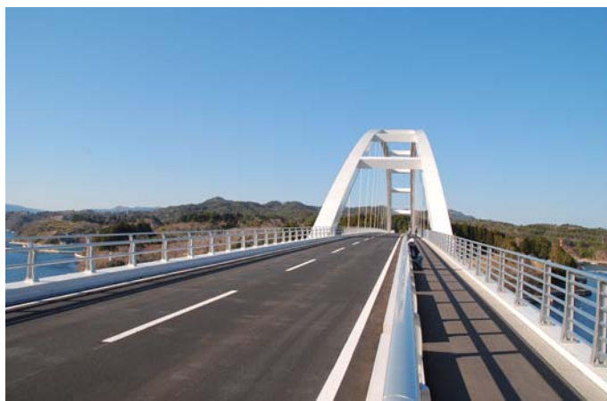
橋脚間の長さは297メートルと東日本最長を誇る気仙沼大島大橋（大島側から撮影）
