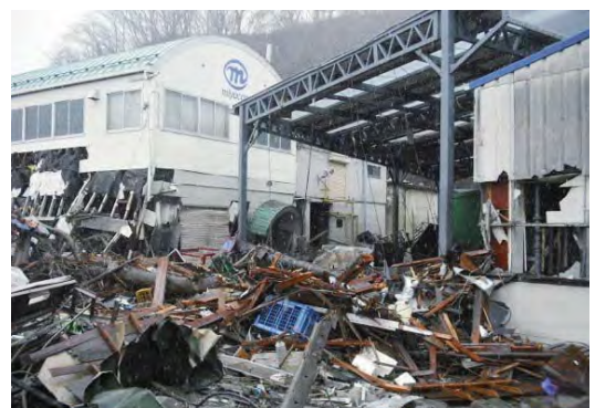
震災当時の被害の様子 工場従業員室 事務所（流出）のあった場所から撮影
