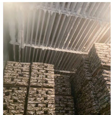
ヘアピンコイル式の保管庫。 乾燥しにくく長期保管に適している
