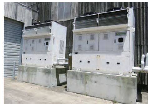
温室効果ガスであるフロンガスを一切使用しない“ノンフロン”冷凍機
