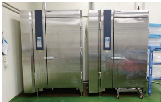
導入したブラストチラー。 表面温度60度の製品が短時間で芯まで冷える
