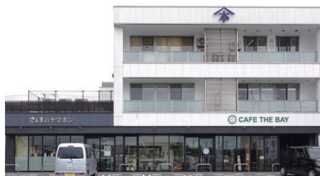
1階に直売所とカフェレストラン、2階には保育園が併設
